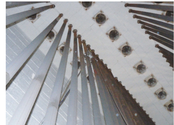
采用 LEO - 扫描系统检测转化炉炉管
